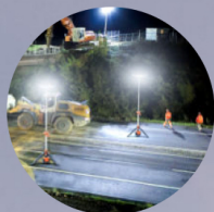
夜間の道路工事
