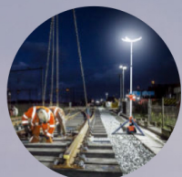
夜間の鉄道補修工事
