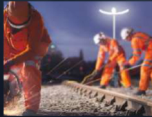
夜間の鉄道保守工事
